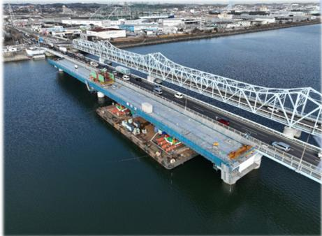
④台船のジャッキを利用して橋桁を橋脚に架けていきます。
