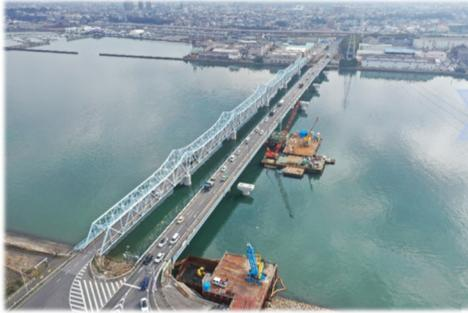
①橋桁を支える橋台、橋脚を工事しています。
