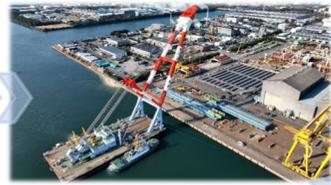
②工場はしげたで橋桁を製作し、クレーン船で台船に載せます。
